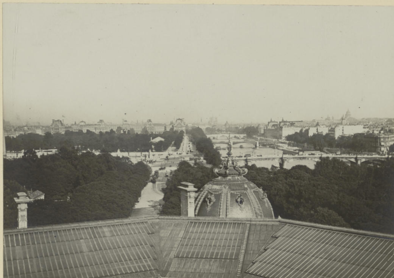
Vue prise du lanterneau de la Coupole
