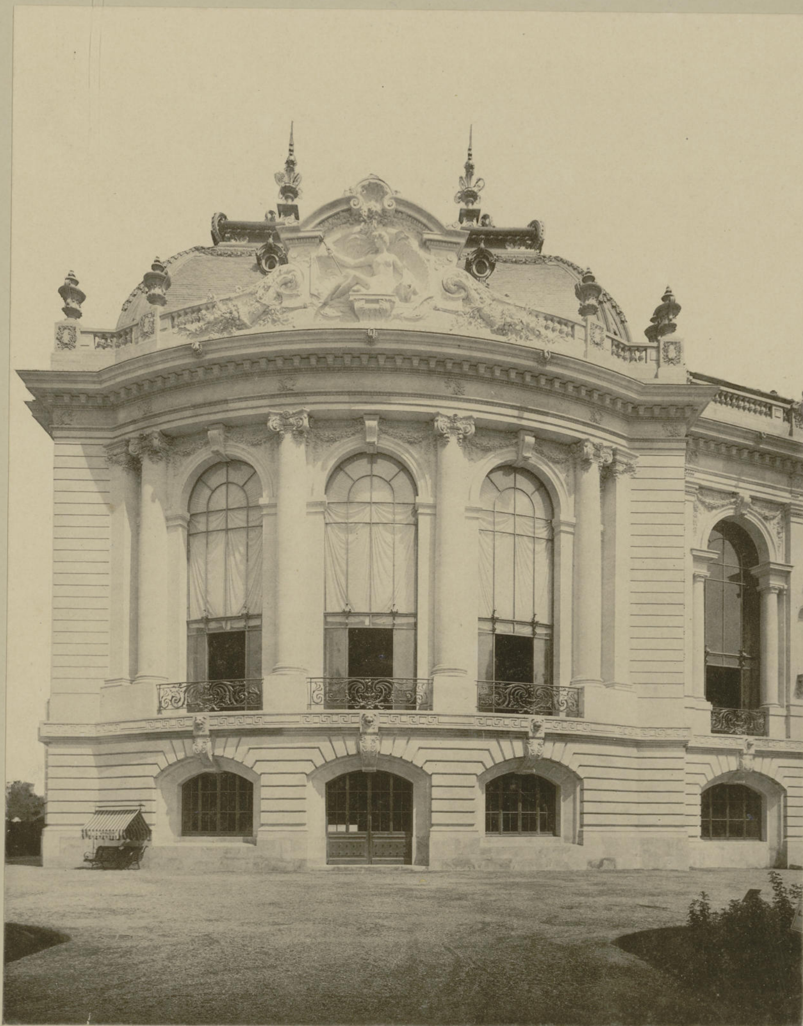
Vue du Pavillon d'angle sur la Façade latérale
