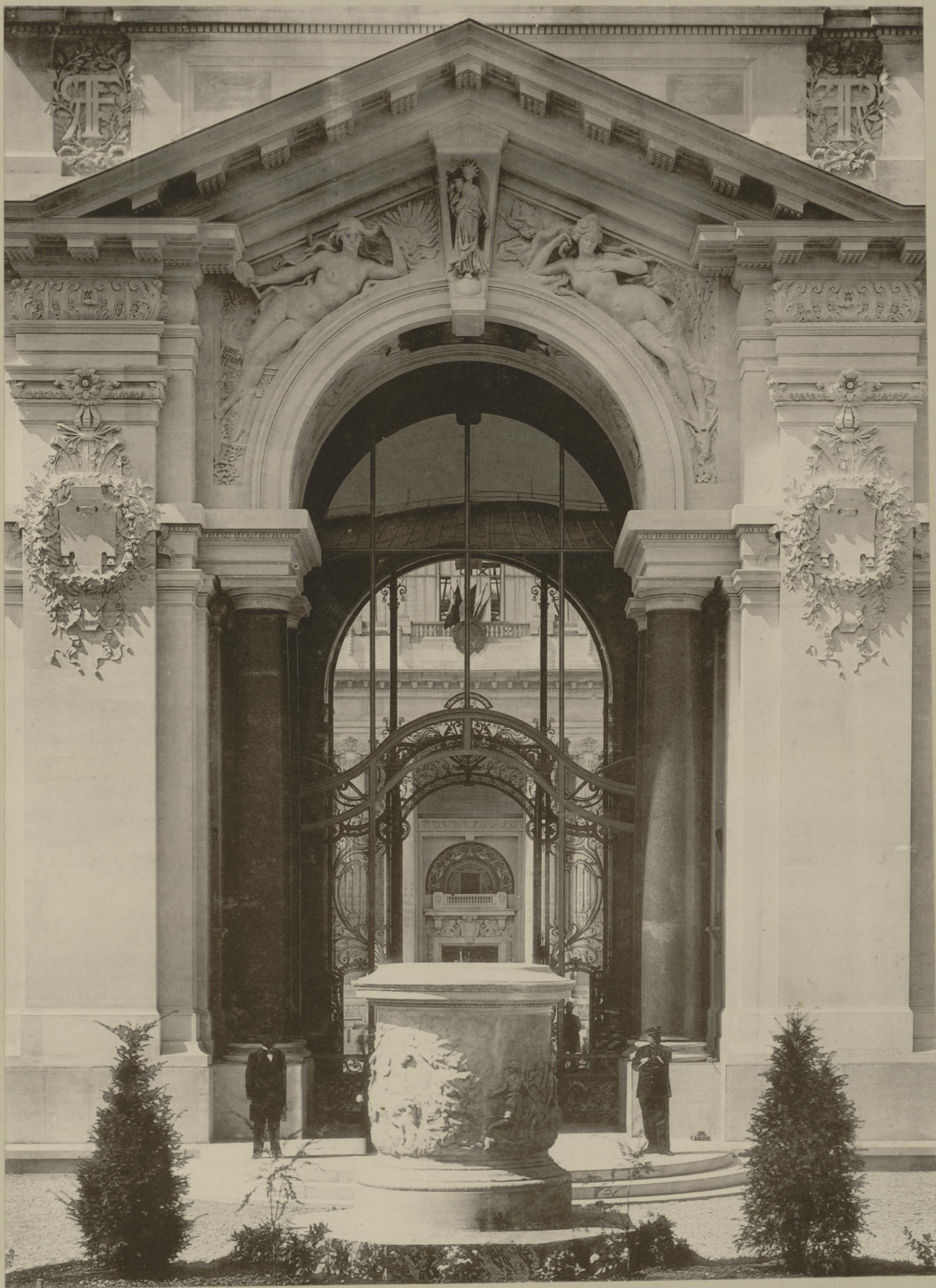
Entrée du dôme sur la cour intérieure
