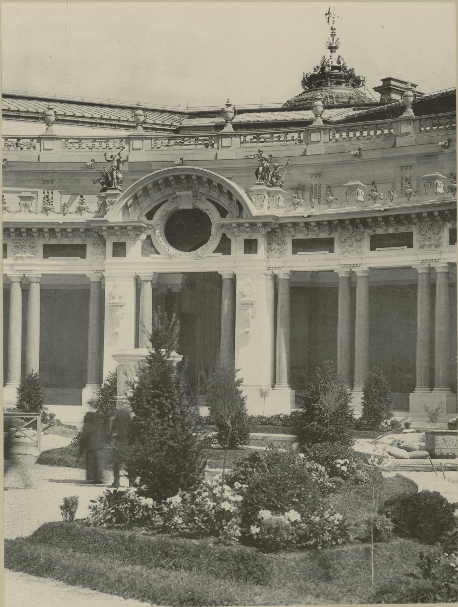
Entrée des Galeries sur la cour intérieure.
