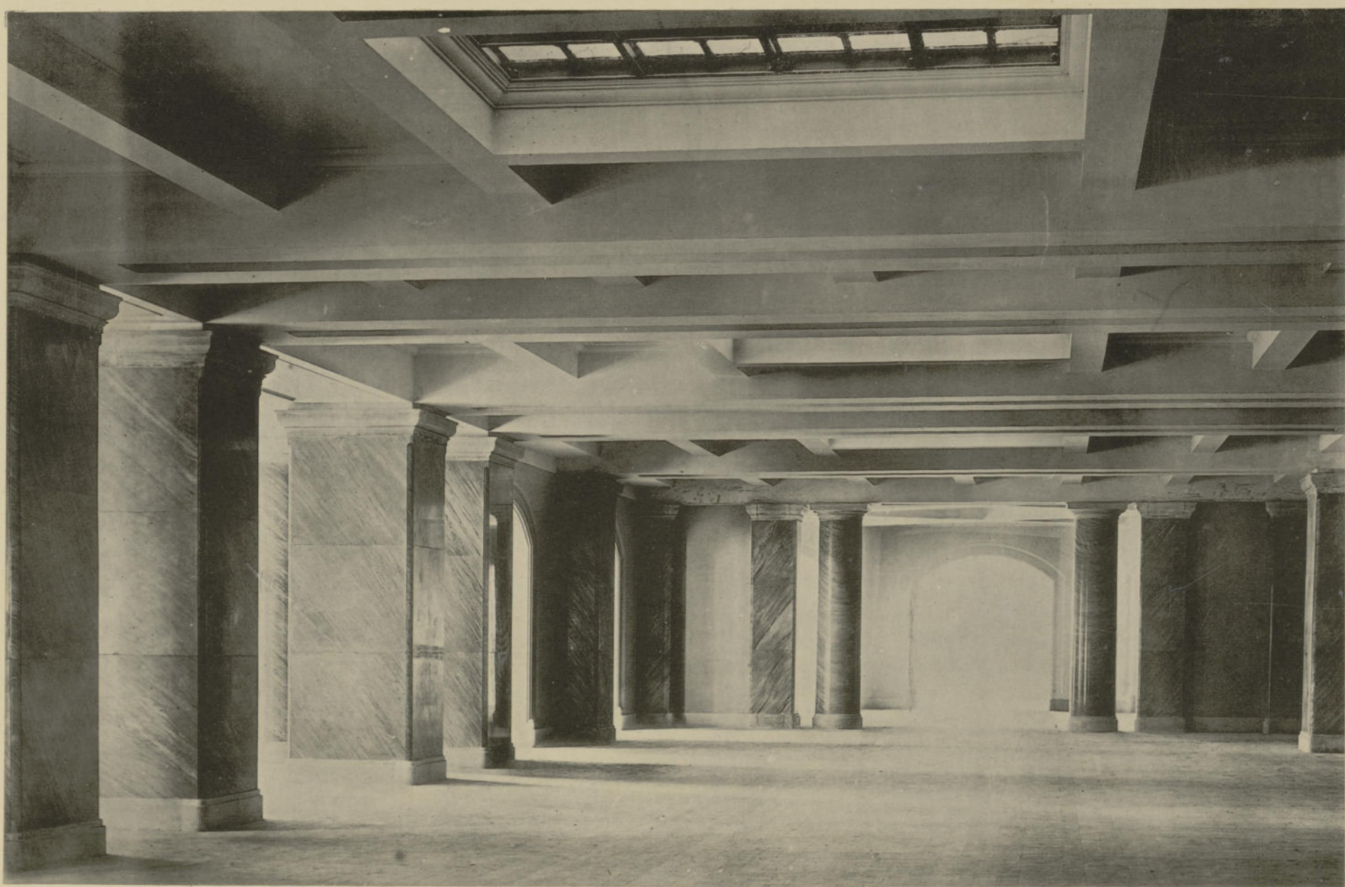
Soubassement - Côté de la Façade Postérieure
