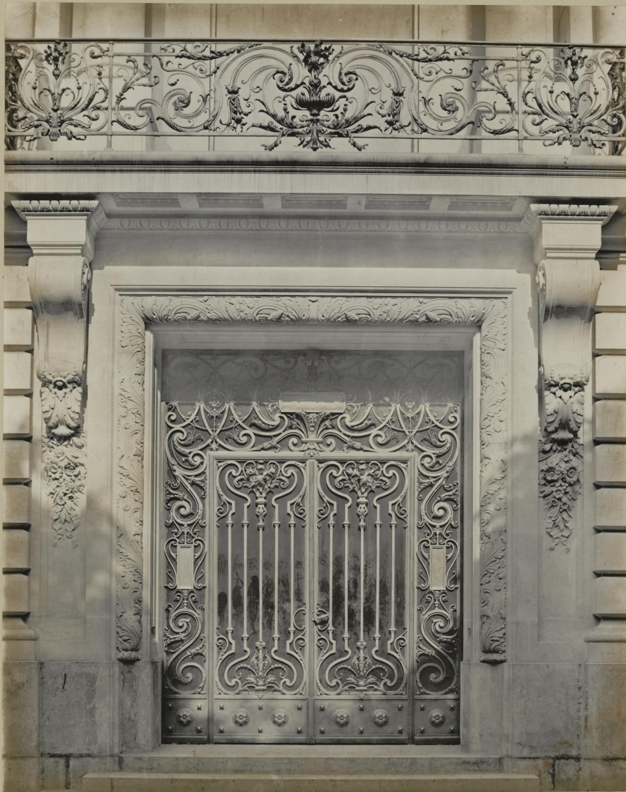
Porte d'Entrée de la Façade Postérieure.
