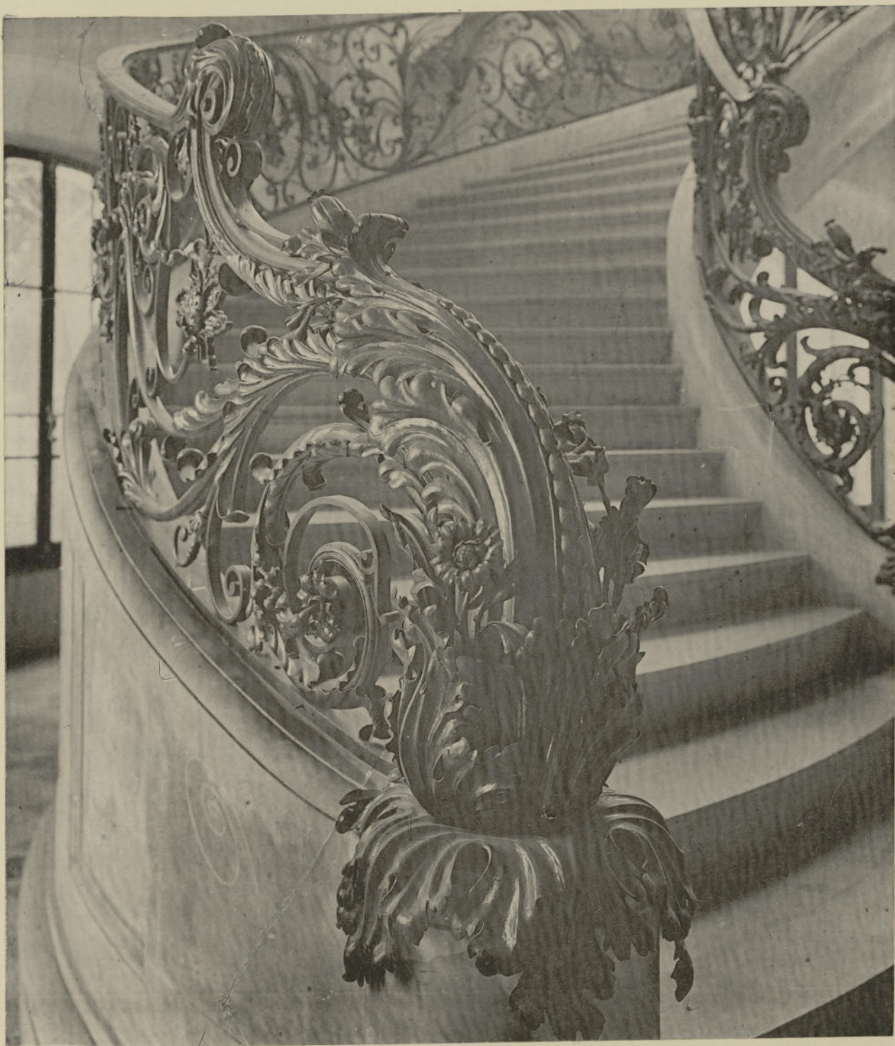
Départ de la rampe en fer forgé des escaliers de la rotonde sur la façade postérieure
