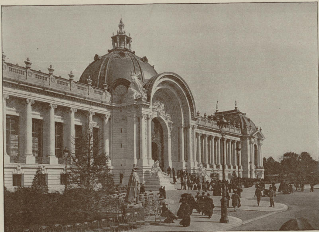
Façade principale du Petit Palais.
