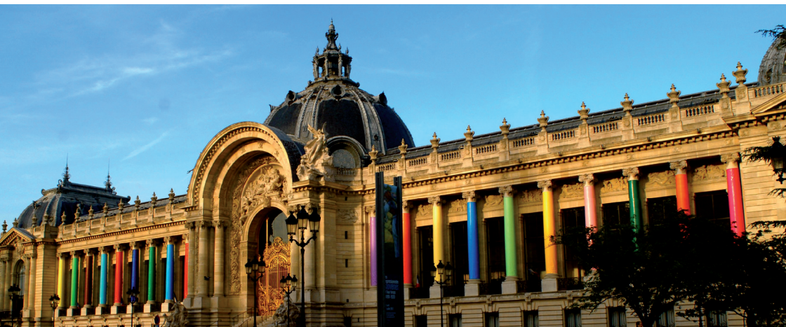
Colonnes habillées avec du Vivaldi-Hris®, 185 g/m²
